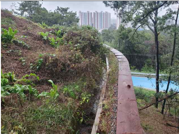
손상내용 옹벽 2단 상부 상태양호
