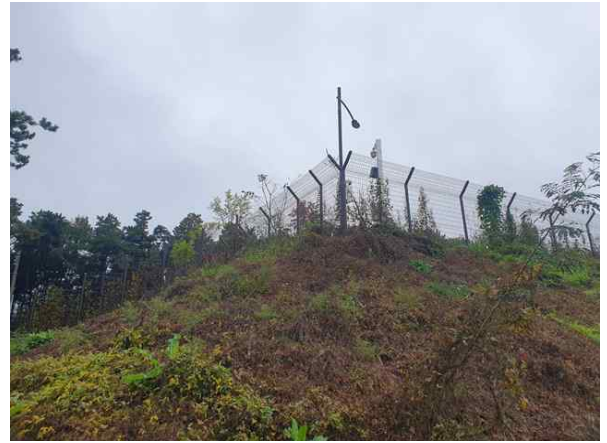
손상내용 안전휀스 상태양호
