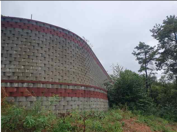
손상내용 옹벽 시점부 상태양호
