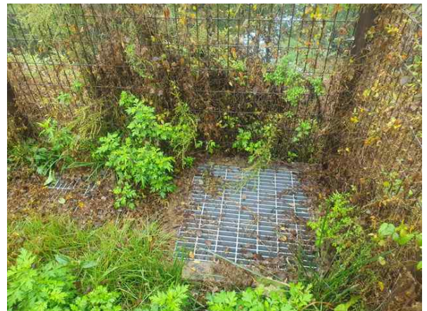
손상내용 배수시설 상태양호
