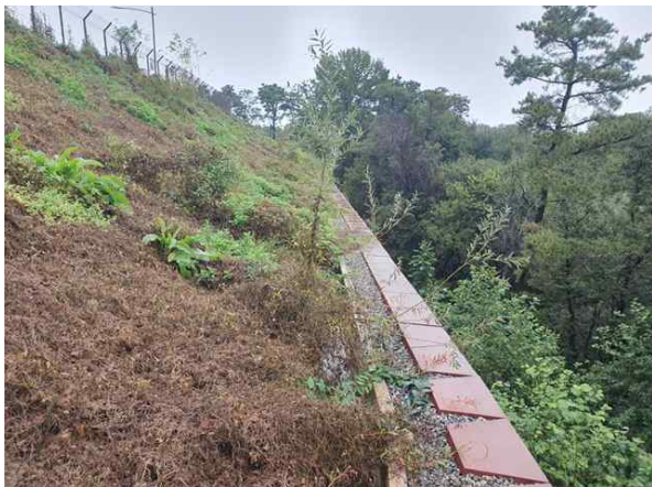
손상내용 배수시설 상태양호
