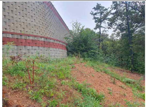
옹벽 하부 전경
