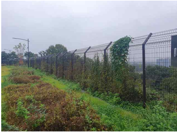
손상내용 안전휀스 상태양호
