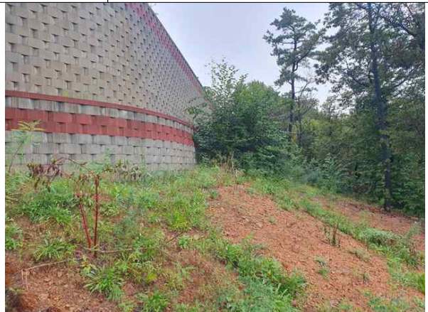
손상내용 옹벽 하부 상태양호
