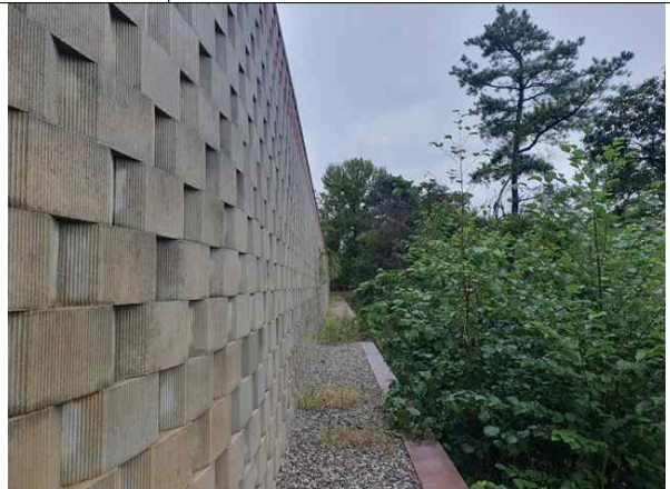
손상내용 옹벽 1단 상부 상태양호
